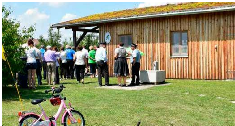
└ Bild 2: Aktuelle Nutzungsansprüche zeitnah umsetzen und dabei regionale Bau-traditionen fortsetzen: Zum Beispiel in Holzbauweise. Die Dachbegrünung sorgt für einen Rückhalt des Regenwassers und kühlt das Gebäude (Foto: Gartenbauzentrum Bayern Süd-Ost)
